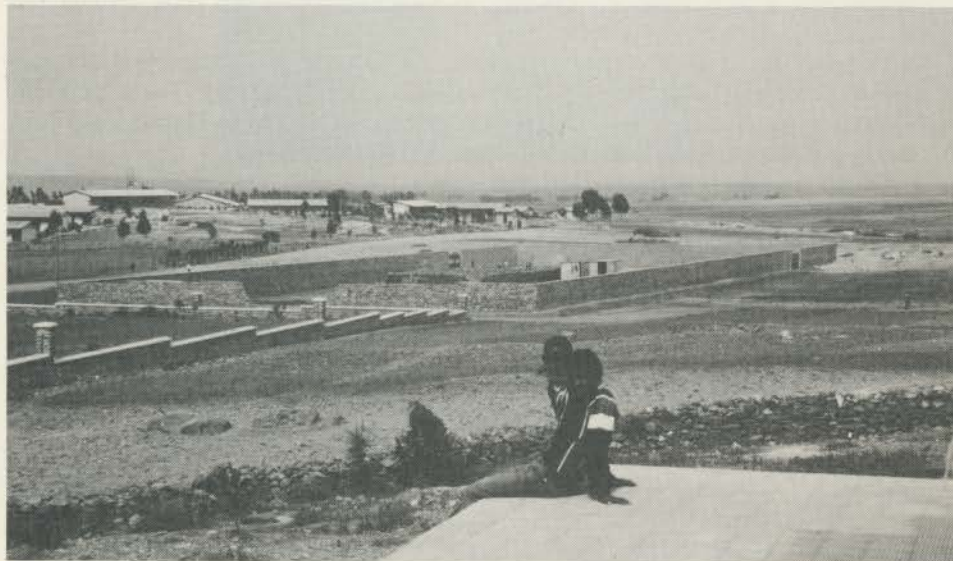
"Centro di Carità": la recinzione ormai ultimata
