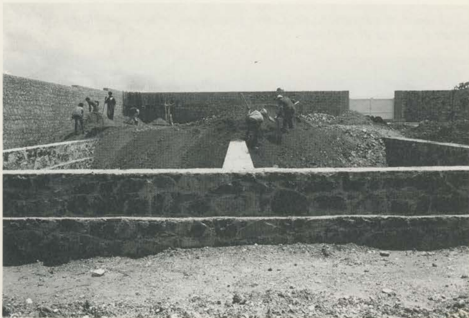
Le fondamenta del 1° lotto di costruzioni
