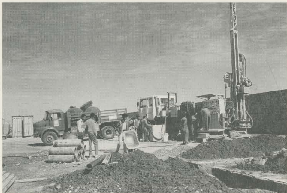
La trivellazione del pozzo
