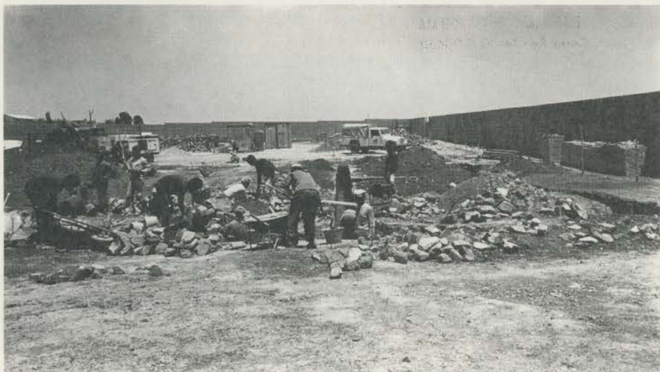
I lavori procedono
