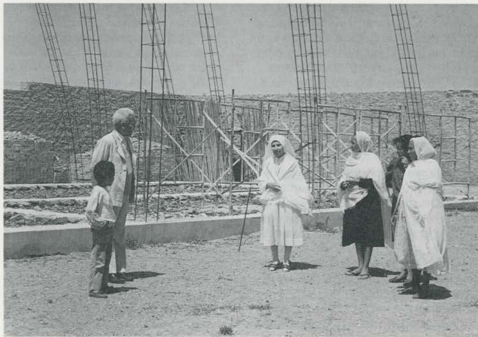
Asmara. Costruzioni in corso al Centro di Carità.
