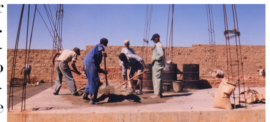
Operai al lavoro per l'edificio in costruzione
