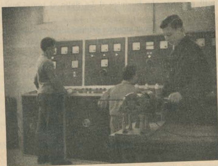
Un particolare del laboratorio elettrotecnico (quadro costruito dagli allievi) Casa di Carità Arti e Mestieri - Torino.
