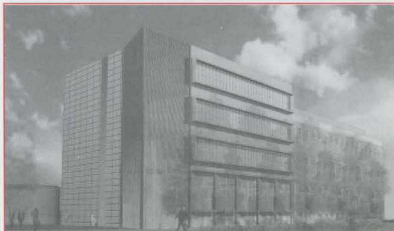
La nuova facciata della Casa di Carità di Torino in fase di realizzazione, con la disponibilità di altre aule.
